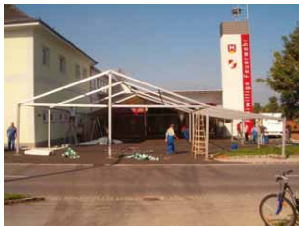
22. bis 24.08.2007: Zeltaufbau für das anstehende Feuerwehrfest
