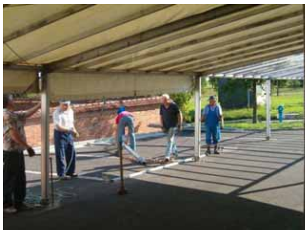
22. bis 24.08.2007: Zeltaufbau für das anstehende Feuerwehrfest
