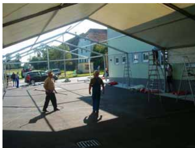
22. bis 24.08.2007: Zeltaufbau für das anstehende Feuerwehrfest
