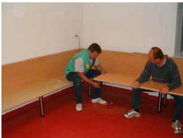
März 2007: Innenausbauarbeiten Feuerwehrhaus
